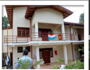
De nieuwe voorgevel
