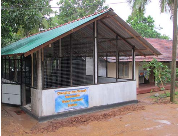
Het gebouw waarin de waterzuiveringsinstallatie zijn werk doet.
