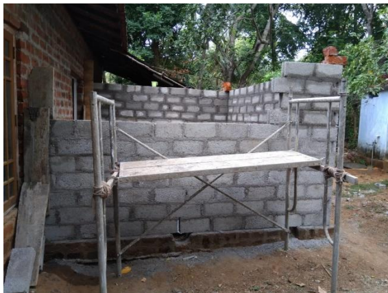
Aanbouw voor douche en toilet
